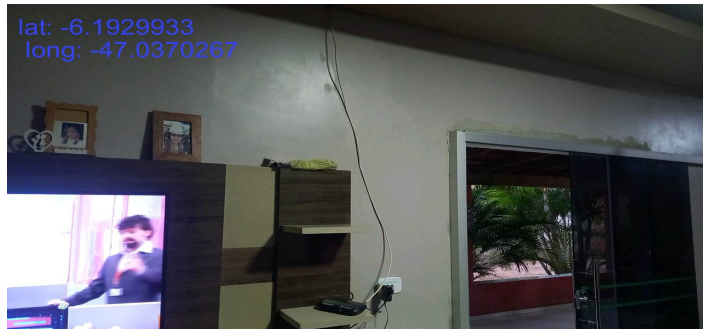
FOTO - PASSAGEM DO CABO DENTRO DA RESIDÊNCIA
