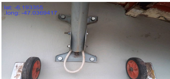
FOTO - FIXAÇÃO DA BASE DA ANTENA
