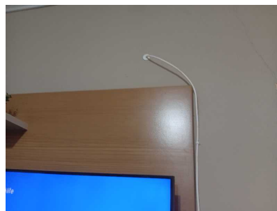
Foto - Passagem do cabo dentro da residência
