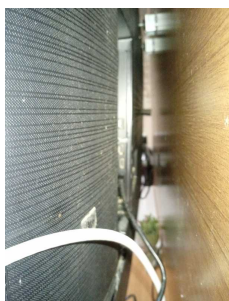
Foto - Fixação da Antena Banda Ku
