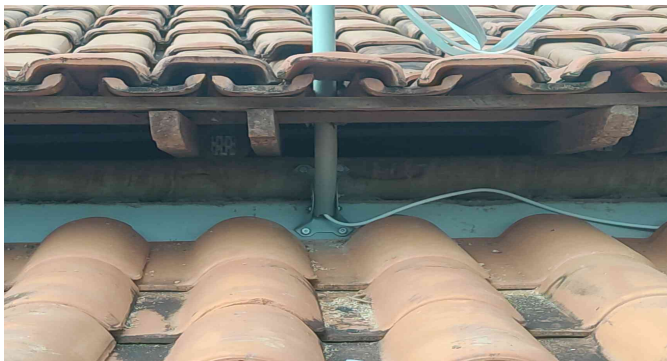
Foto – Fixação da Base da Antena
