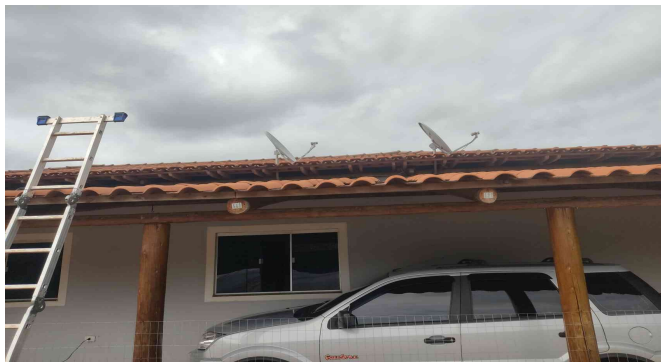
Foto – Antena Banda Ku Instalada
