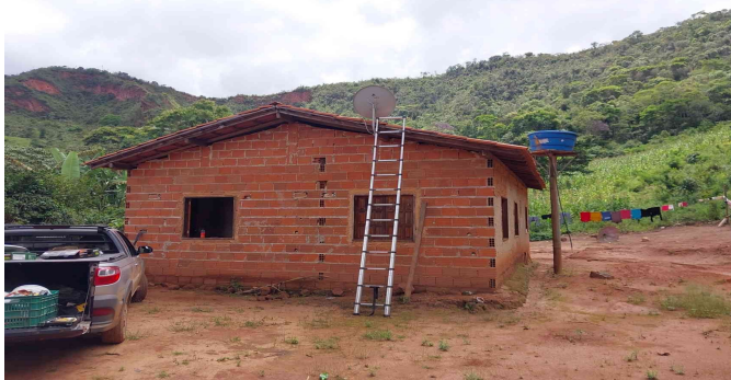
Foto – Fachada da Residência
